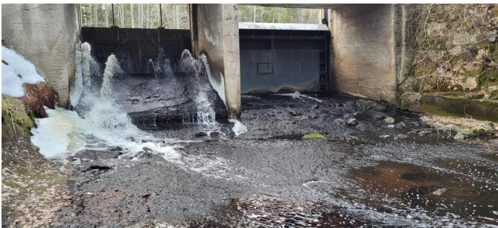
Nyhammardammens dammluckor helt stängda i januari 2023.
